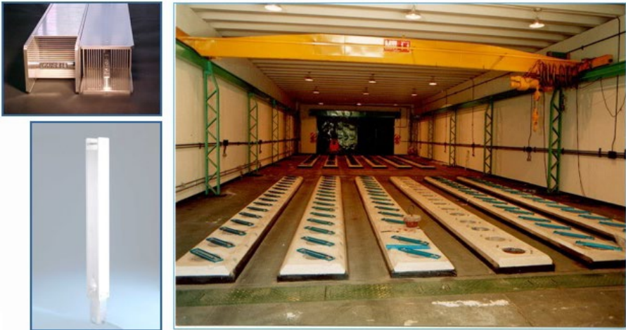
Figura 6. Almacenamiento de los EECC del reactor RA-3
