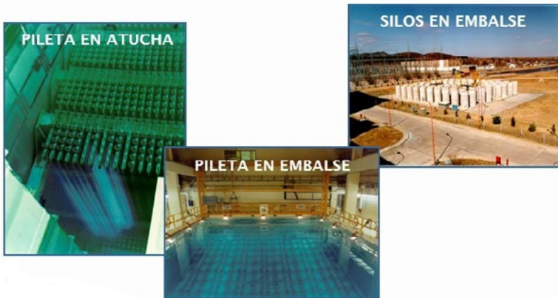
Figura 4. Piletas y silos en las centrales nucleares argentinas
