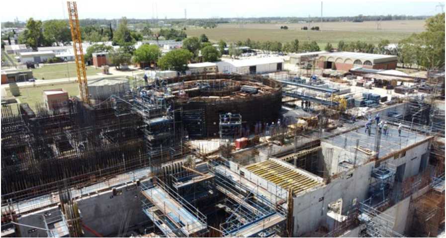
Figura 12. Obras del reactor CAREM-25 25
