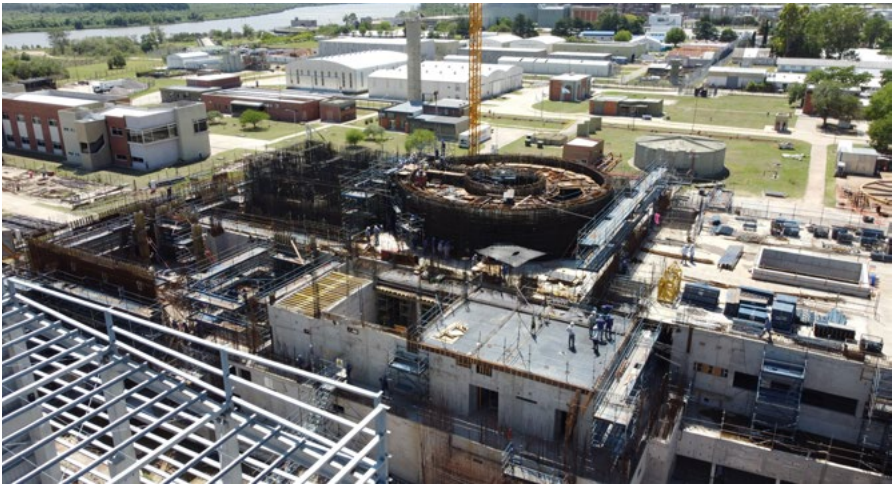
Figura 14. Obras del reactor CAREM-25
