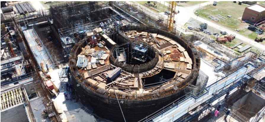
Figura 13. Obras del reactor CAREM-25
